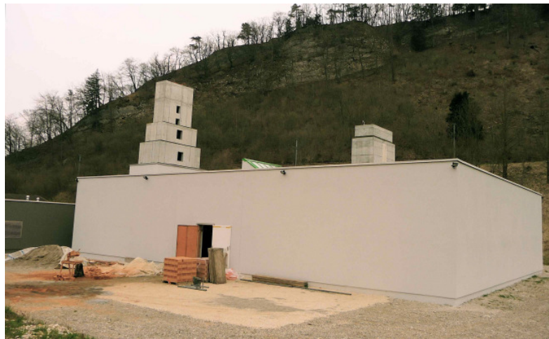
Bild 4: Bauprozess des Sri Manonmani Ampal Tempels bei Trimbach (Foto: Eulberg 2010)
